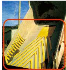
ダンプトラックベッセルの補強
